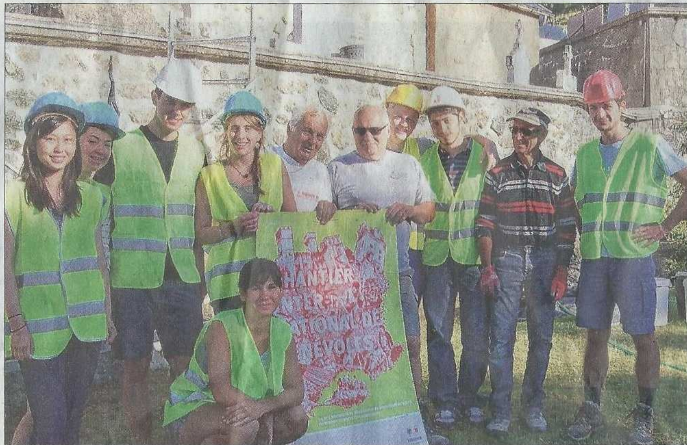
Cette année, huit jeunes âgées de 18 à 23 ans ont participé au chantier de l'association Jeunesse et reconstruction. Il s'agissait cette année de rénover le mur du cimetière.
