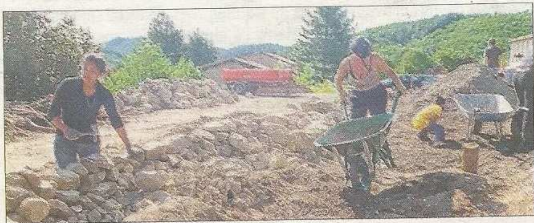
Création d'un muret.
