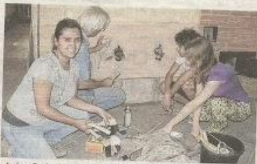
■ Le jour, ils s'activent sur le chantier du fort du Paillet. Photo Pascal Géhin
