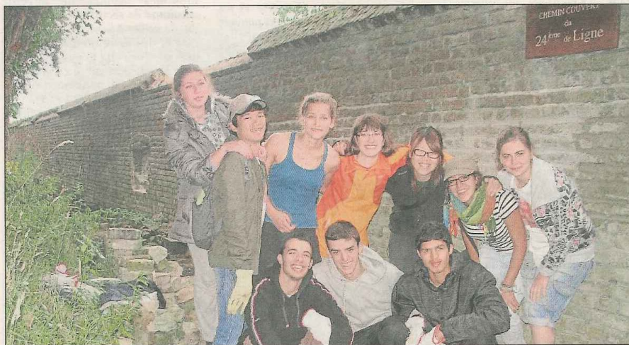
Les jeunes du chantier de reconstruction sont arrivés le 11 juillet et repartiront le 1 er août.
