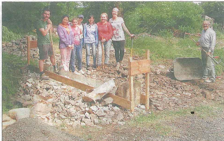
TRAVAUX. Les étudiants qui s'activent sur le chantier viennent des quatre coins du globe.
