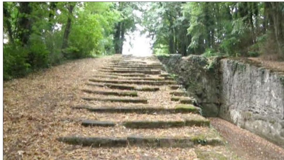
Les marches des escaliers séculaires avant et après les travaux.
