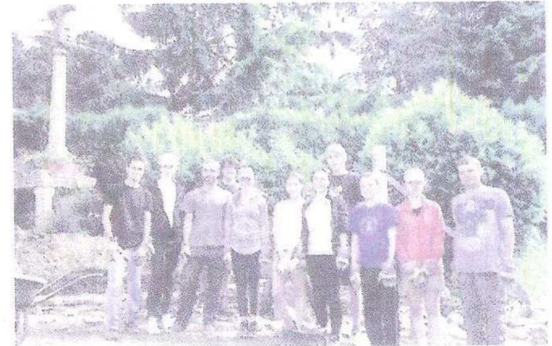
■ Les jeunes du chantier s'affairent à la construction d'un muret en pierres à proximité du hameau des tours. Photo Aurélien Sperandio
