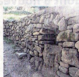
■ Reconstruction de murets en pierres sèches
