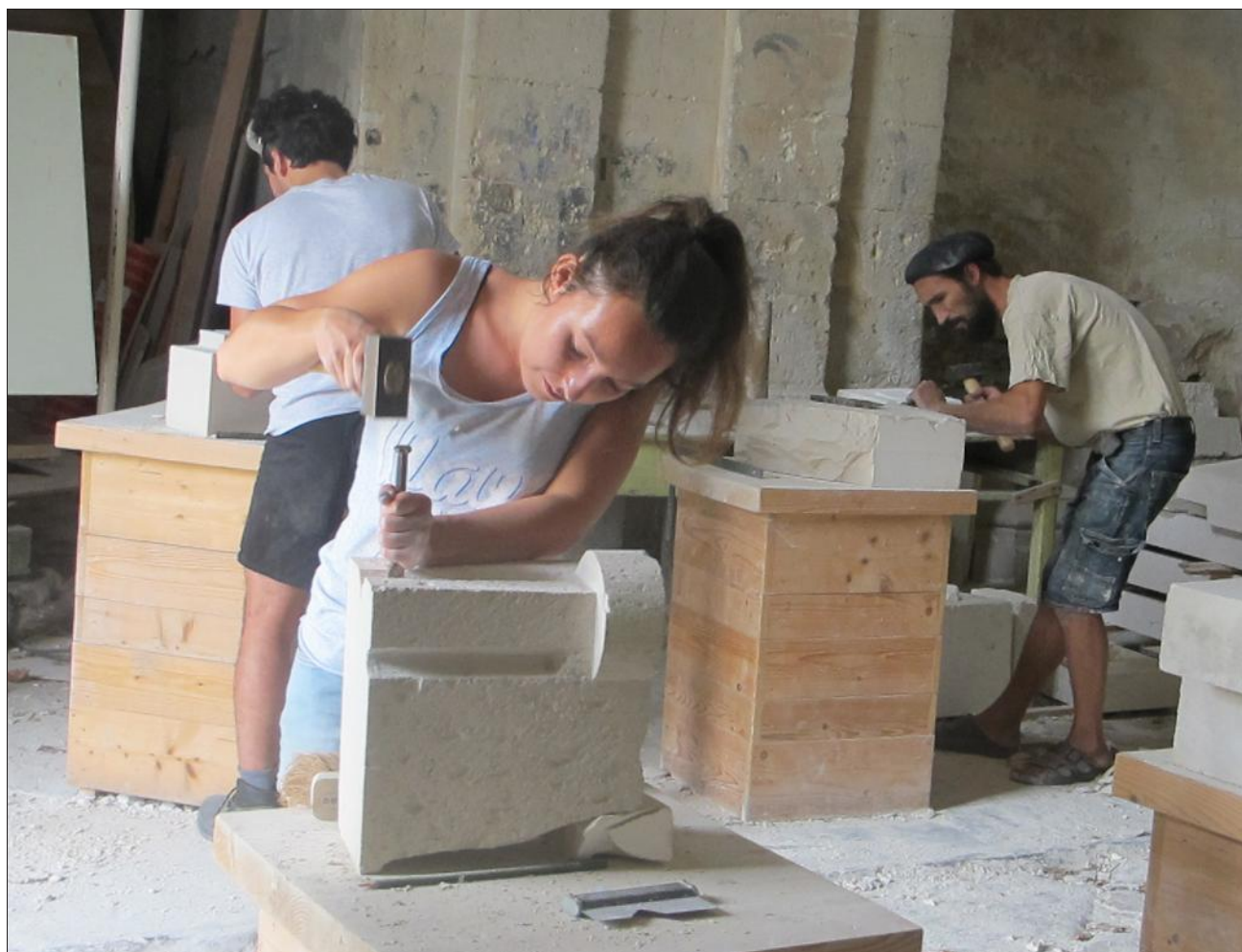
Les deux groupes de jeunes alternent entre taillage de pierre et mise à niveau du sol. La première activité se déroule dans la chapelle du Rhône, encadrée par Ludovic Morand (à gauche). Photos Le DL/MA.
